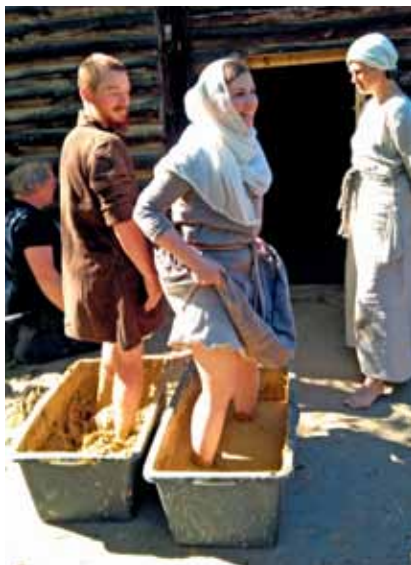
Abb. 2: Lehm vorbereiten für den Stampfboden. Foto: Brigitte Jusuf, Co. Fördererkreis Preparing clay for a cobb floor.
