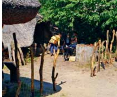
Abb. 11: Die Zaunpfosten vor dem Einflechten der Haselruten. | Foto: Tom Lüdicke The fence posts before adding the hazel rods.
