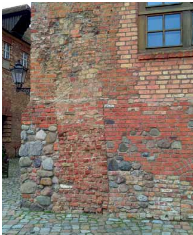
Abb. 8: Ansatz der spätmittelalterlichen Ringmauer in der Ostfassade des Palas. Deutlich zu erkennen ist, dass der Palas an die bestehende Ringmauer angesetzt wurde
