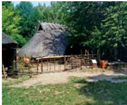
Abb. 12: Der fertige Zaun. | Foto: Tom Lüdicke The finished fence.
