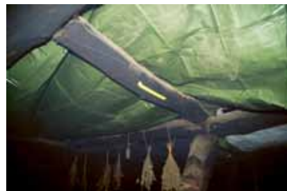
Abb. 19: Planen wurden als Zwischendeckenersatz eingefügt, um den Rauch direkt nach oben zu leiten. Foto: Tom Lüdicke Tarps were used as a fake ceiling to channel the smoke directly to the top of the house.
