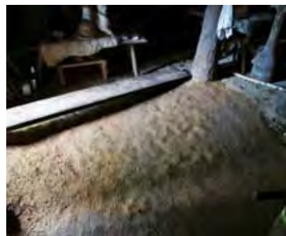
Abb. 22: Der neue Lehm Boden am Eingang. Foto: Tom Lüdicke The new clay floor at the entrance.
