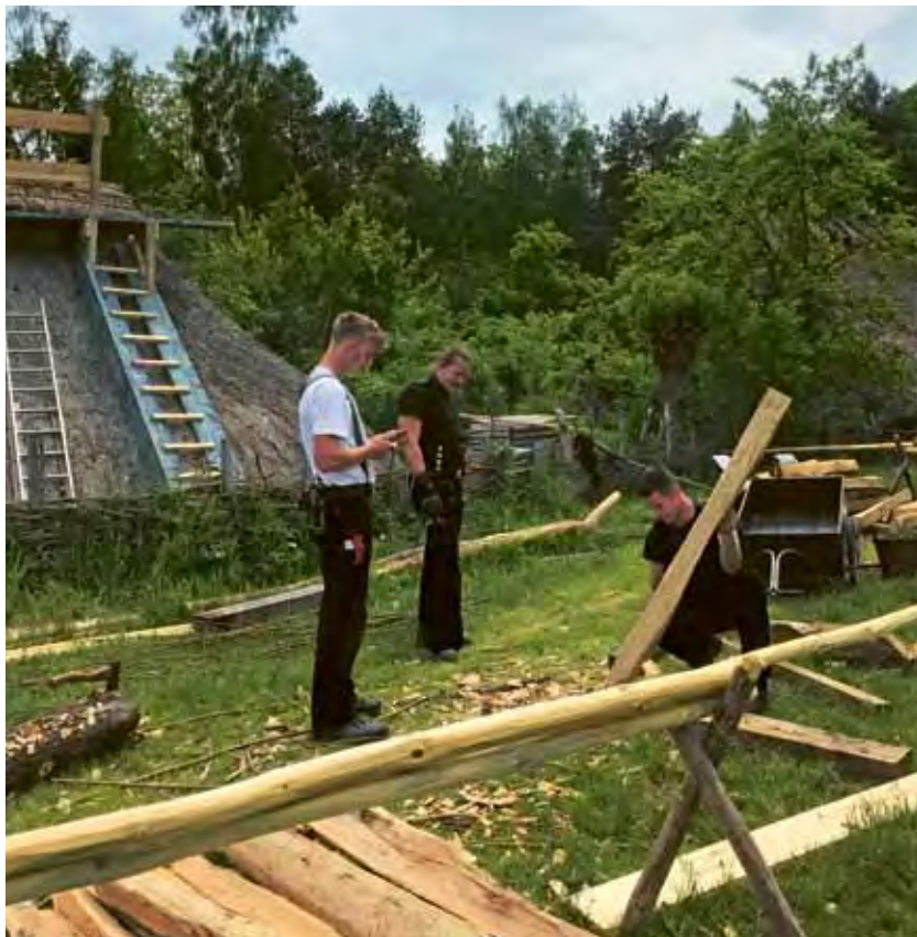
Abb. 3: Die Auszubildenden der Knobelsdorffschule ersetzen die Dachreiter mit neuen Eichenspaltingen. Foto: Julia Heeb
