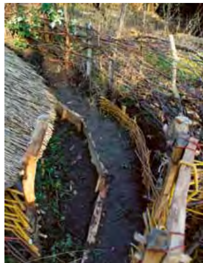
Abb. 24: Spaltbohlen als Traufgrabenbefestigung. Foto: Tom Lüdicke Split planks used as ditch enforcements.
