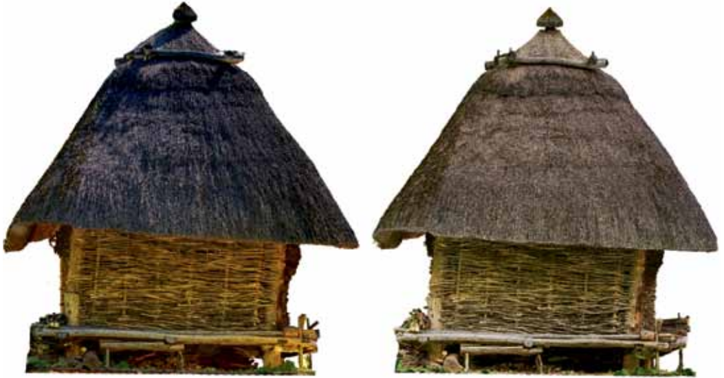
Abb. 2: Zwei Aufnahmen eines Gebäudes zu unterschiedlichen Zeitpunkten. Links: Aufnahme bei Sonnenschein. Rechts: Aufnahme bei bewölktem Himmel. Foto: Arie Kai-Browne Two images of a building captured at different times. Left: Captured in sunlight. Right: Captured under a cloudy sky.
