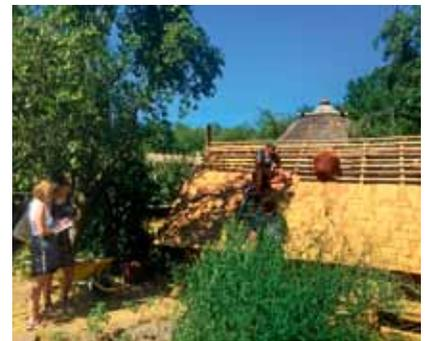
*Abb. 1: Das Holzschindeldach wird gedeckt.*
