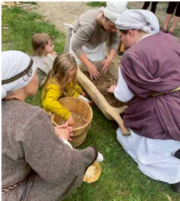
Abb. 23: Der alte zerstampfte Lehm mit frischem Lehm, Wasser und Stroh vermengt. Foto: Anna Mitsou Förster © Förderverein Museumsdorf Düppel The old tamped clay mixed with fresh clay, water and straw.
