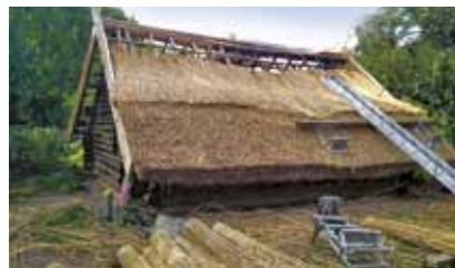
Abb. 4: Beginn der Arbeiten am Dach.
