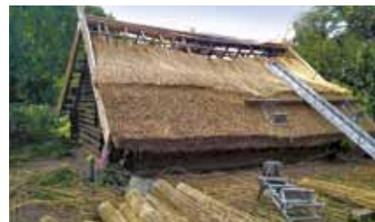
Abb. 4: Beginn der Arbeiten am Dach.
