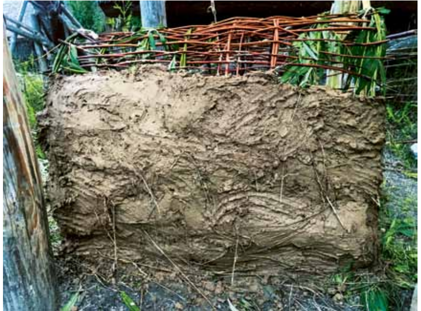
Abb. 41: Die erste Lehmsschicht wird aufgetragen. | Foto: Ilka Kühne © Förderverein Museumsdorf Düppel The first layer of clay is applied.
