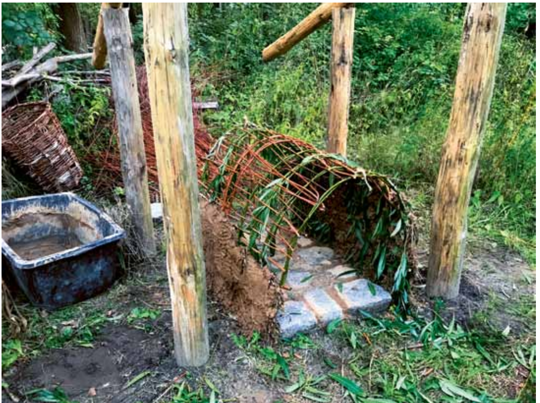
Abb. 40: Bodenplatte und Weidenrutengerüst. | Foto: Ilka Kühne © Förderverein Museumsdorf Düppel The base of the oven with the wicker frame.
