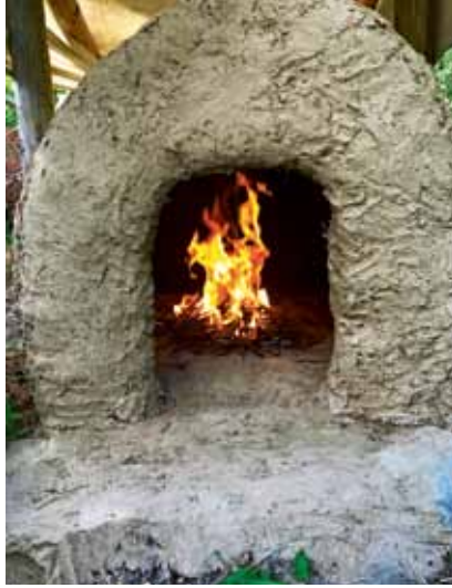
Abb. 43: Der Backofen wird trocken geheizt. Foto: Ilka Kühne © Förderverein Museumsdorf Düppel The oven is dry-fired.
