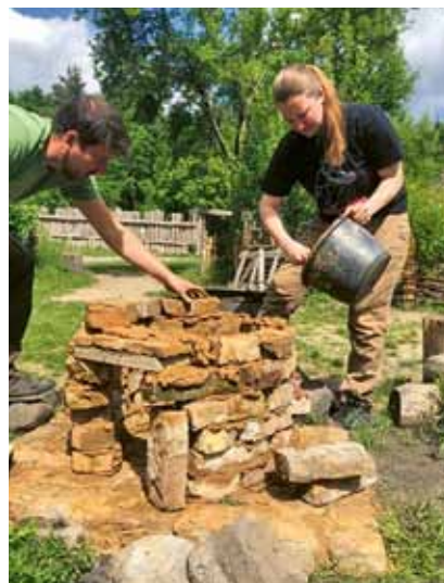
Abb. 8: Bau des Brauofens. Foto: F. Standke © Förderverein Museumsdorf Düppel Building the brewing oven.
