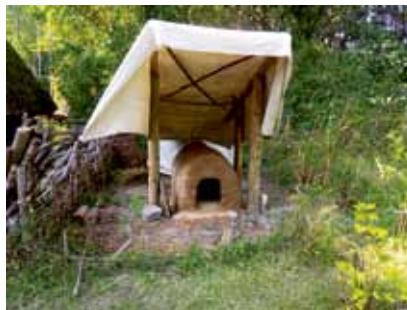
Abb. 42: Der fertige Backofen mit provisorischem Dach. Foto: Ilka Kühne © Förderverein Museumsdorf Düppel The finished oven with the temporary roof.
