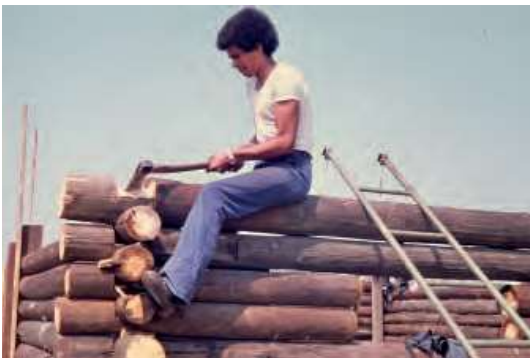
In den 70er Jahren beginnen die Ehrenamtlichen die Häuser auf den mittelalterlichen Grundrissen zu errichten und mittelalterliche Handwerkstechniken zu nutzen © Landesdenkmalamt Berlin
