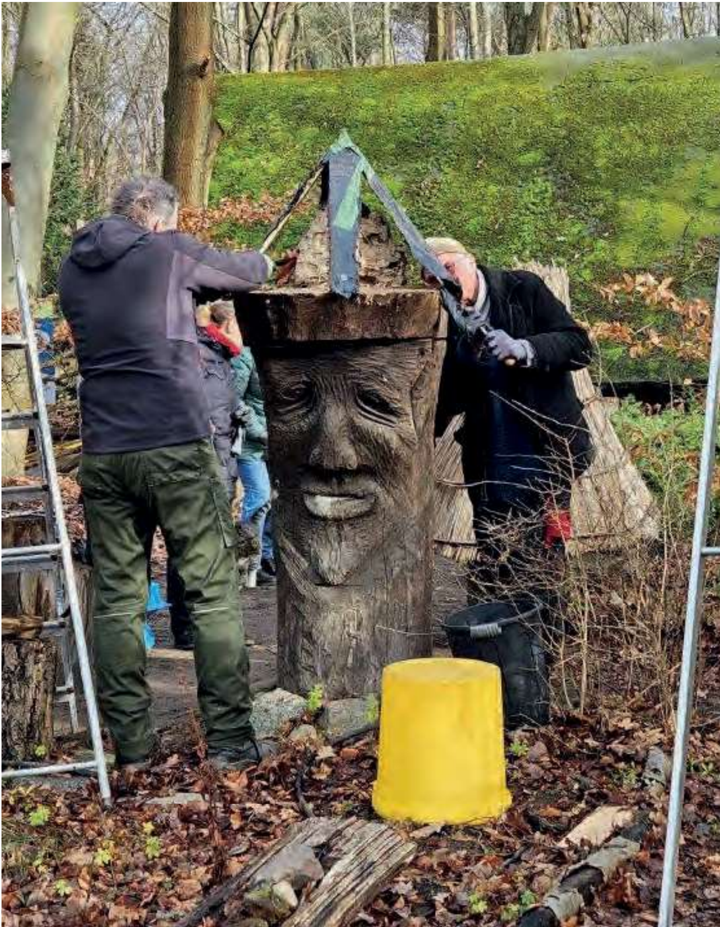
Dacherneuerung der Klotzbeute „Ambrosius“ © Imkergruppe
