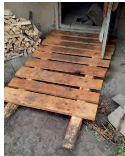
Bild 2: neuer Zugang für Haus 4 © Christian Huß
