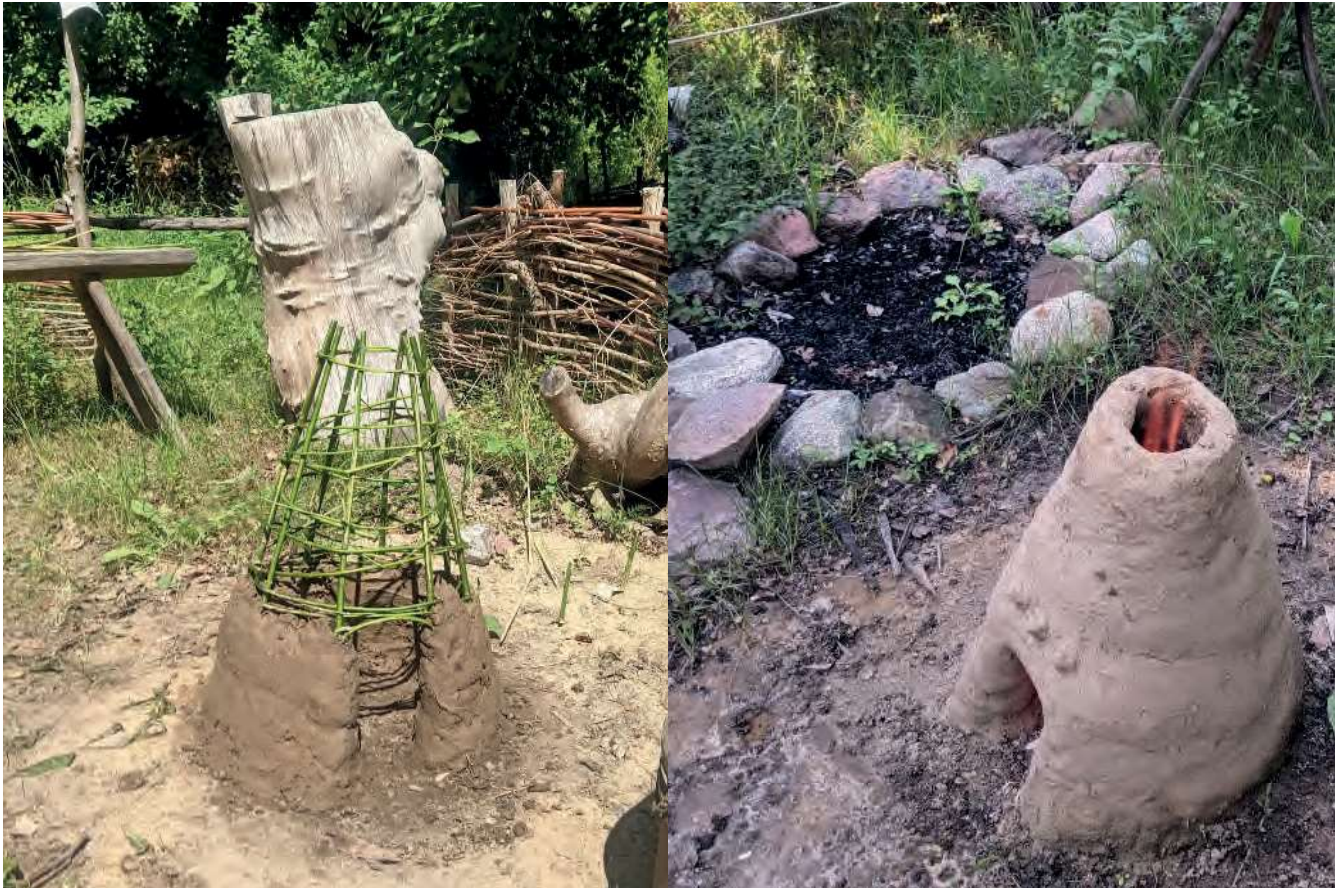
Bau und Probefeuern des Perlenofens © Ilka Kühne
